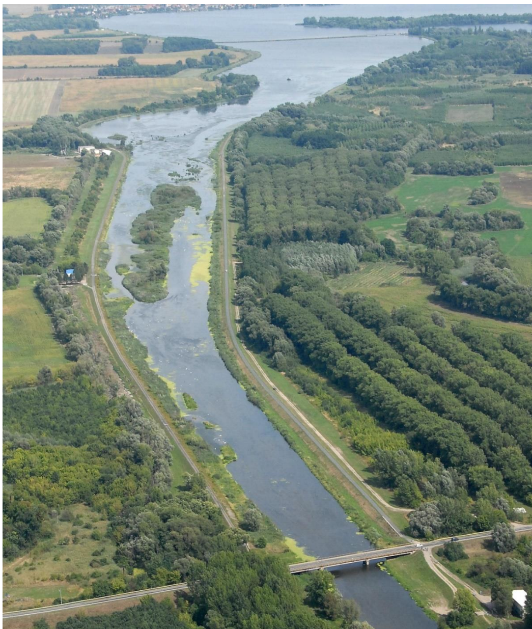
Obr. 2. Zanášení nádrže a zarůstání nánosů (Povodí Moravy, 2018)
